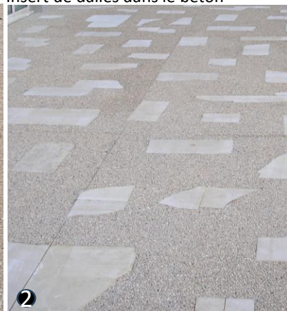
Insert de dalles dans le béton
